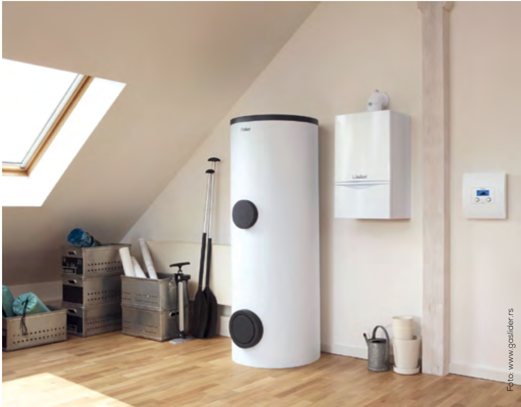
Primer akumulatora tople vode u sistemu grejanja
